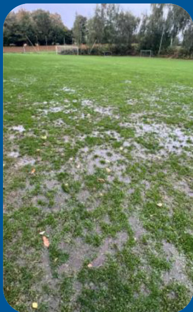
Abbildung 3: Fußballplatz, der kein Wasser mehr aufnimmt; Da die verlegte Drainage verstopft, wird eine Tiefen-Aerifizierung als Sanierungsmaßnahme angedacht
